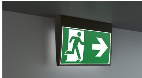
Automatische Überwachung der Sicherheitsleuchte mit SelfControl.
